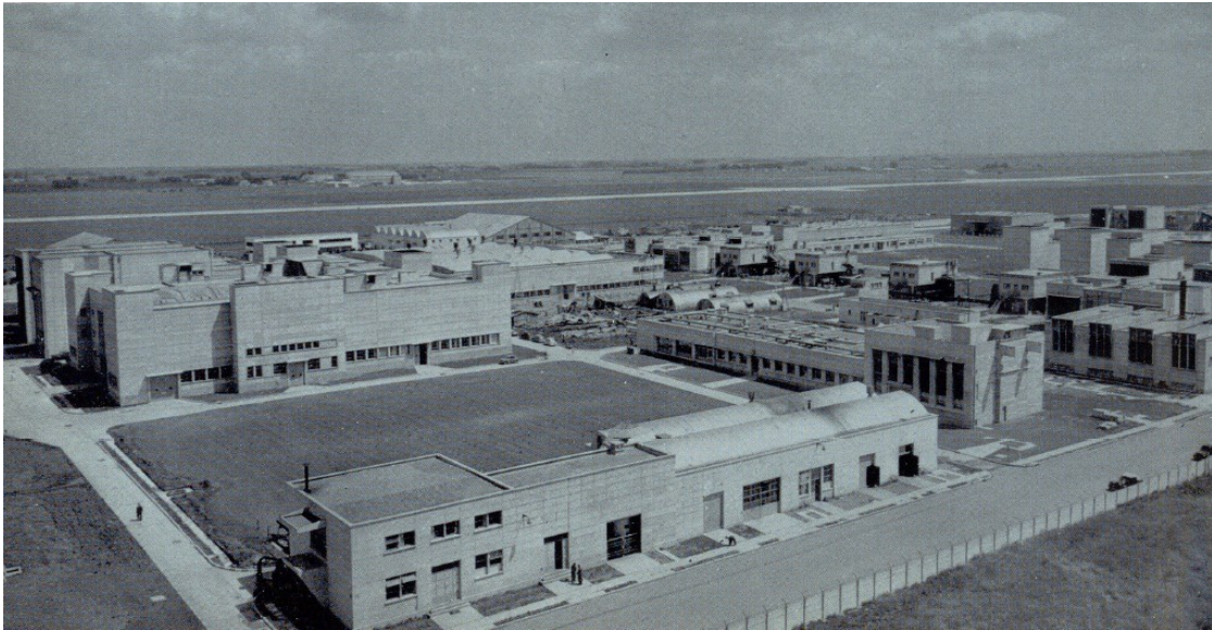
Installations d'essais à Melun-Villaroche
